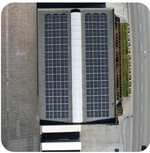
Parc photovoltaïque de Plastuni Opérations
