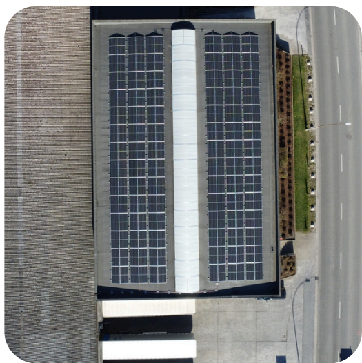
Parc photovoltaïque de Plastuni Opérations
